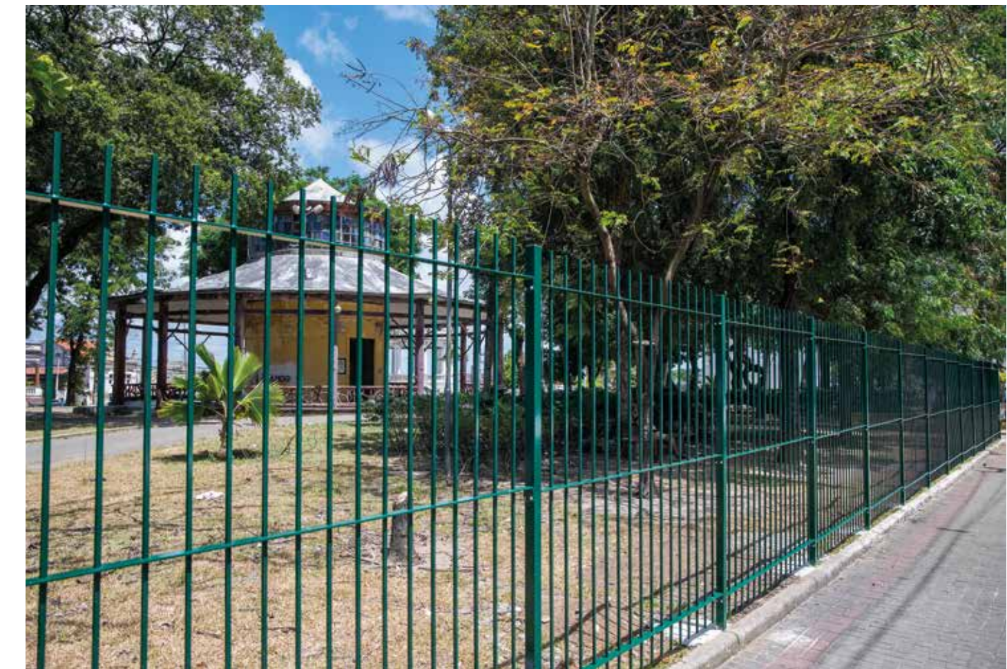
Serão instalados um café e um restaurante-escola; atualmente, praça tem acúmulo de lixo e presença de usuários de drogas
