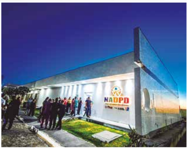
Chefe do Executivo estadual acompanhou a reforma da fachada e da recepção da unidade hospitalar e fez uma visita ao Núcleo de Apoio e Diagnóstico à Pessoa com Deficiência
